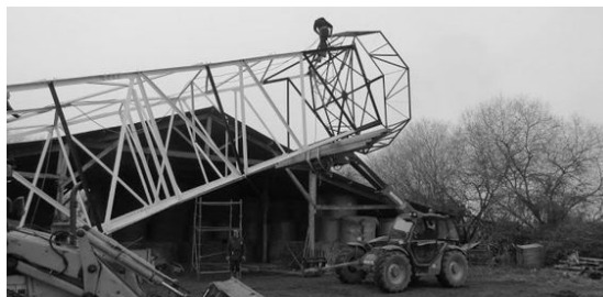
pour mémoire... moyens utilisés pour lever le phare de la Rolandière
